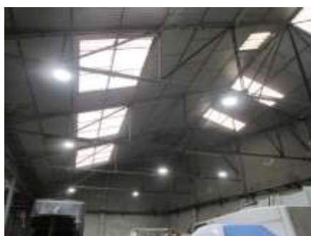
Lucernarios en las naves de aparcamiento
